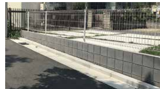
[新設フェンス]
