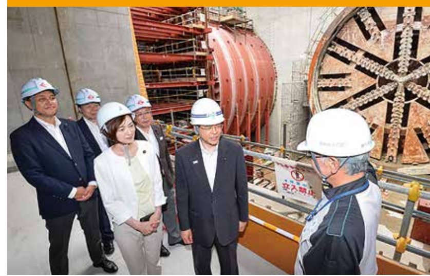
横浜環状北西線の建設現場
